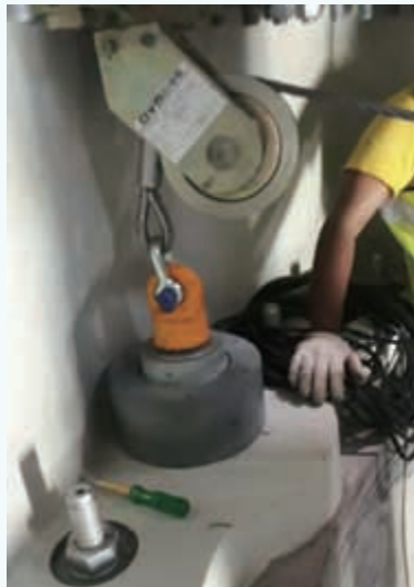
图13 上端螺母安装
