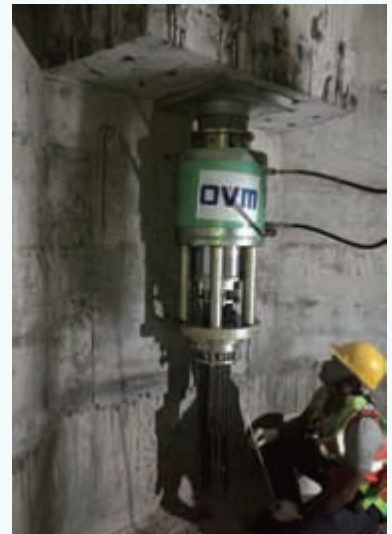
图14 塔基础内悬浮张拉施工
