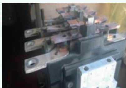
图10 并网滤波接触器发生了严重的烧蚀图片
