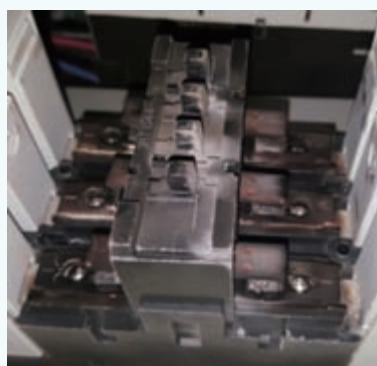
图8 液压站电机接触器的烧蚀图片
