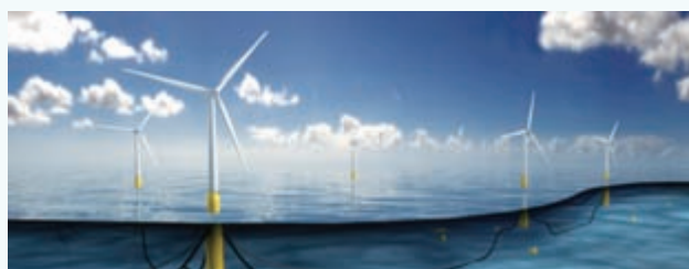
图1 挪威国油苏格兰“海风”（Hywind）风电场 （整个风电场由5台6MW“海风”浮式机组组成）
