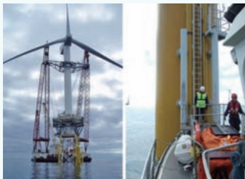
图3 海上风电现场运维实景图
