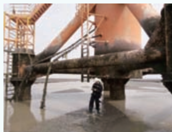
图2 #39多管桩基础海生物生长严重
