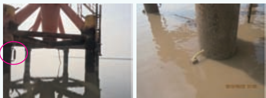
左:低潮位牺牲阳极块裸露 右:阳极块安装后 图7 牺牲阳极块增加安装前后
