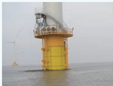
图9 单管桩基础包覆防腐效果
