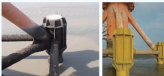
图6 多管桩基础包覆前后对比
