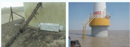
图5 牺牲阳极块安装(左)、运行保护(右)
