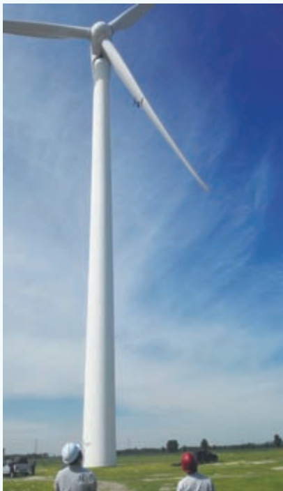
图10 无人机现场巡检照片
