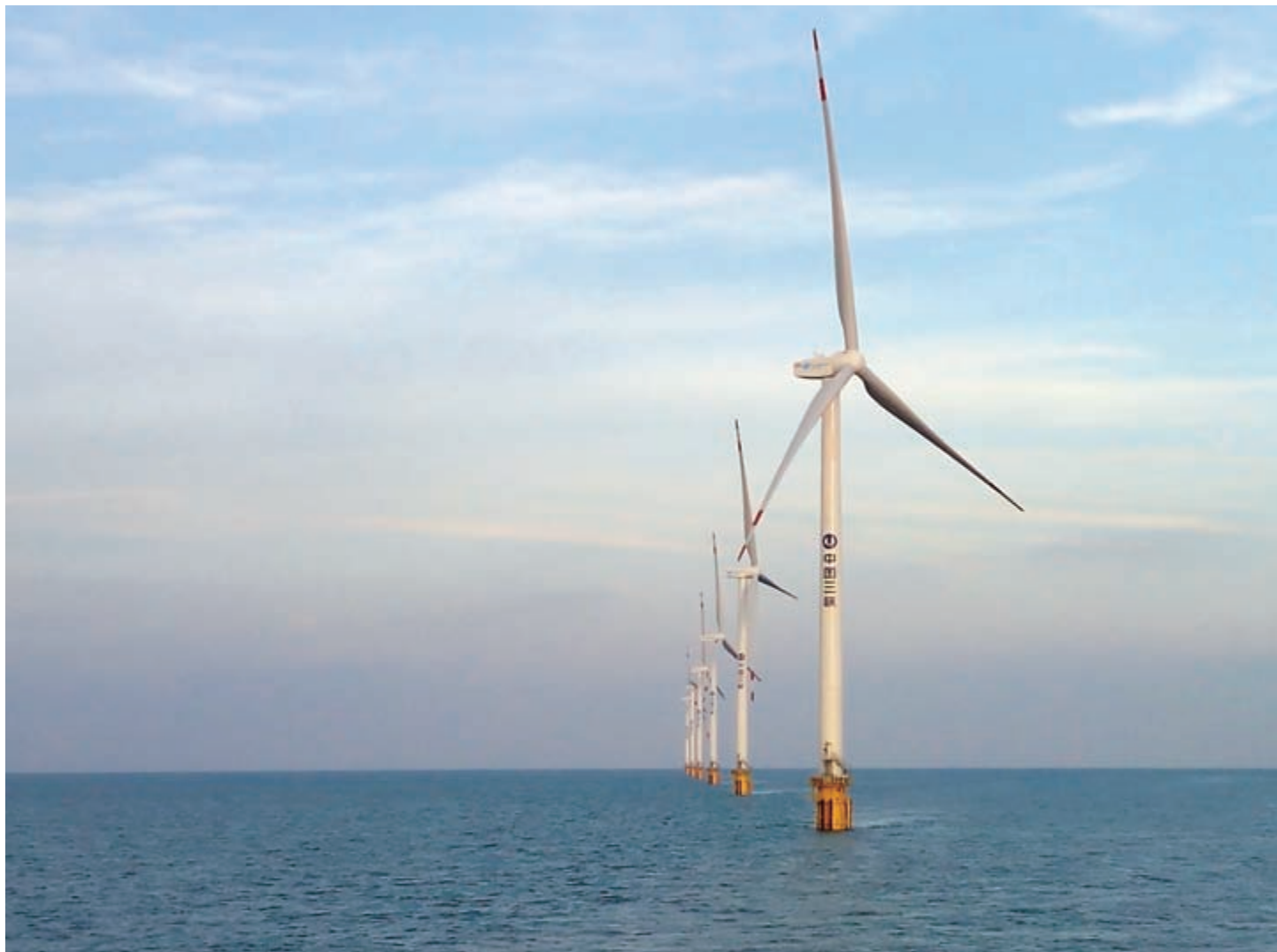
▲ 金风科技江苏响水近海三峡风电场项目
