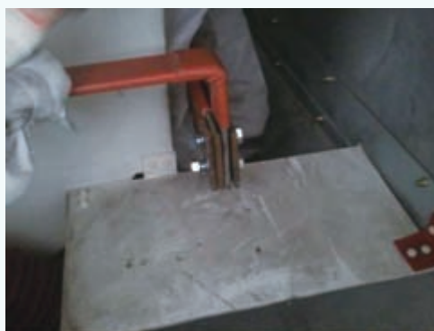
图2 母线室水平绝缘板积灰严重
