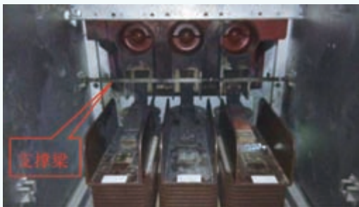
图1 故障后的电缆室
