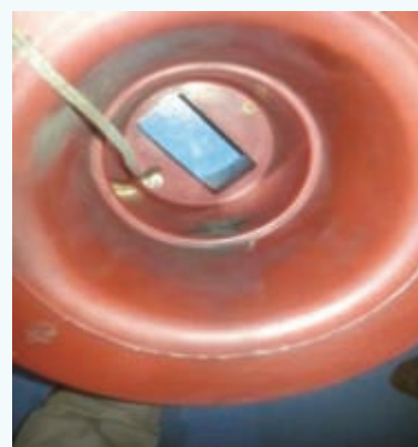
图6 穿箱套管及屏蔽线
